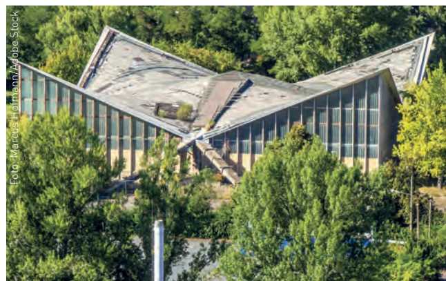
Die nach ihrer Konstruktion „Hyparschale“ genannte Mehrzweckhalle in Magdeburg soll saniert werden.
