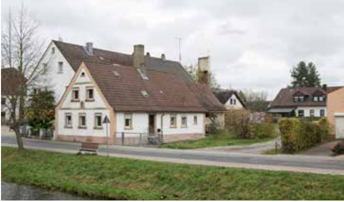
Der Bauernhof in Gundelsheim vor Beginn der Erweiterungs- und Umbauarbeiten
