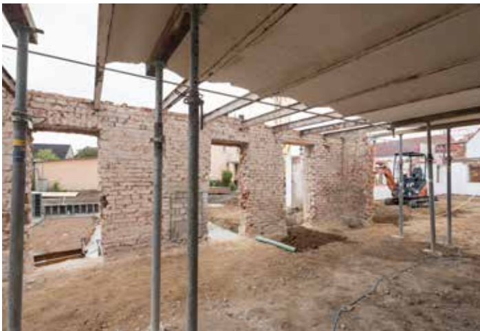
Oben links: Eine neue Bodenplatte musste auf den zuvor für die Lüftungskanäle angelegten Bodenschächten eingebaut werden
