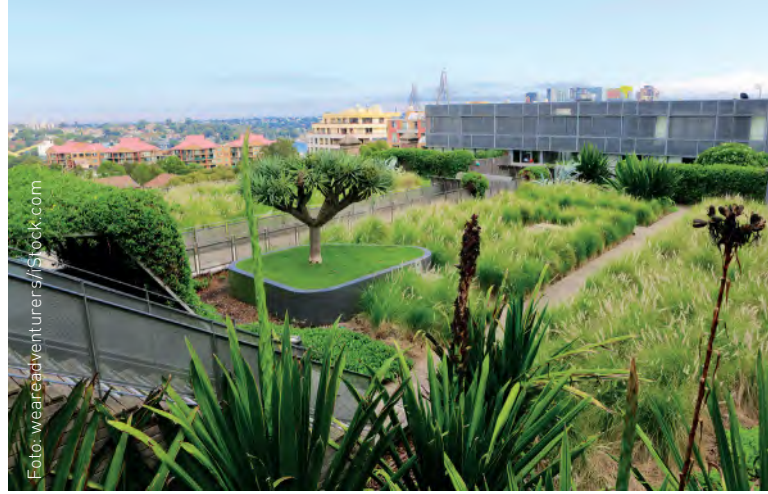
Begrünte Dächer wirken kühlend und fangen Regenwasser auf.
