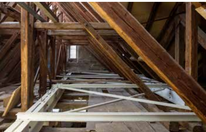
Im Dachgeschoss ist die Stahlkonstruktion zur Lastabtragung und Aussteifung des historischen Holztragwerks sichtbar
