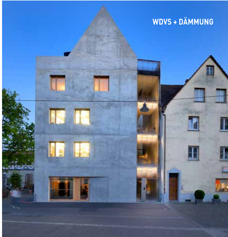
Der Einsatz des Dämmbetons für den Bau des Wohn- und Geschäftshauses K5 ist eine Reaktion auf die Umgebung des Grundstücks, den mittelalterlichen Stadtkern Ulms
