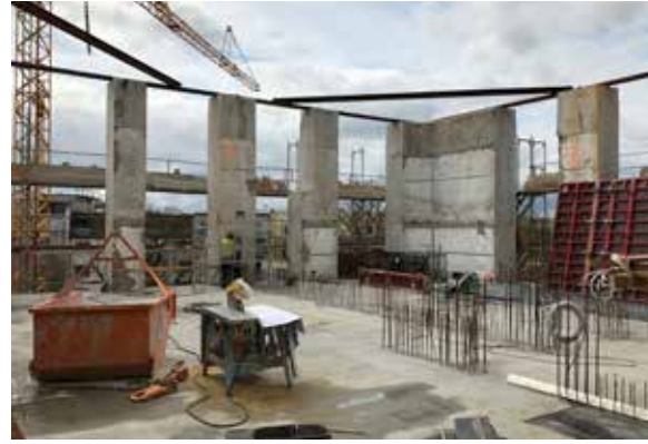
Während der Schlitzarbeiten wurde am oberen Ende der Außenwände ein Ringbalken aus Stahlprofilen als Provisorium eingebaut Fotos: Björn Christopher Liese
