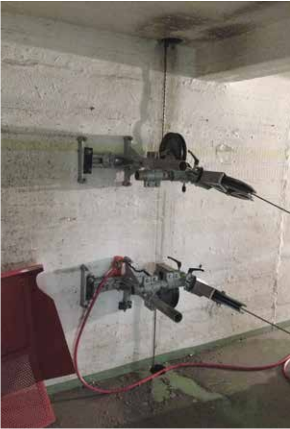
Mit der Mauersäge wurden die Öffnungen für die Fenster in die 1,10 m dicken Betonaußenwände geschnitten
