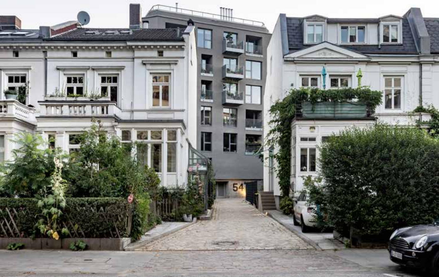
Aus zweiter Reihe lugt der umgenutzte Bunker im Hamburger Stadtteil Ottensen zwischen die klassizistischen Wohnhäusern hindurch Foto: Roland Borgmann Fotografie
