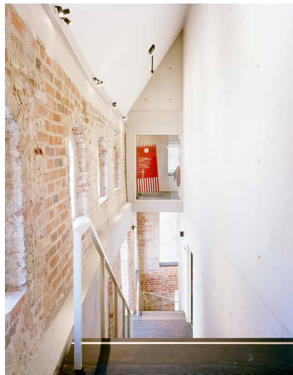
Abb. 40: Haupttreppenlauf im 2. OG; Blick treppabwärts [© Konermann Sigmund Architekten BDA Stadtplaner/Alexander de Cuveland]
