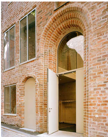
Abb. 32: Eingangsportal des Museums; links eine ehemalige Kellertür [© Konermann Siegmund Architekten BDA Stadtplaner/Alexander de Cuveland]
