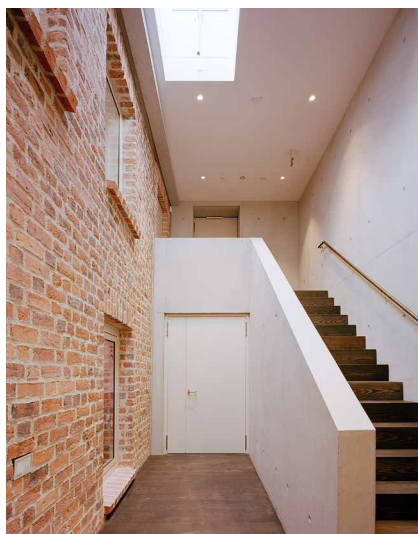
Abb. 25: Die ehemalige Außenwand des Kolk 14 wird hier zur Innenwand der Erschließung im Neubau [© Konermann Siegmund Architekten BDA Stadtplaner / Alexander de Cuveland]
