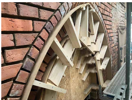
Abb. 21: Mithilfe eines hölzernen Lehrgerüsts wurde der Spitzbogen des Portals gemauert [© Cornelius Back]
