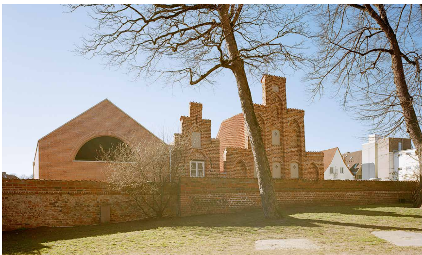
Abb. 28: Vom erhöhten Vorplatz der Petrikirche können die Zuschauerinnen und Zuschauer die Vorstellung auf der Außenbühne verfolgen [© Konermann Siegmund Architekten BDA Stadtplaner / Alexander de Cuveland]
