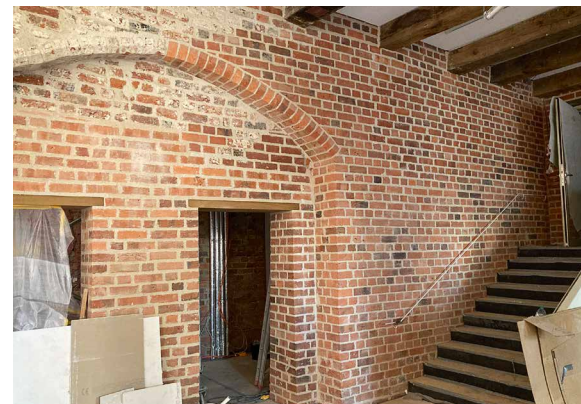
Abb. 18: Im Foyer ergänzte die Restaurierungsfirma den historischen Bogen an der Wand zum Gebäude Kolk 16 | © Nüthen]
