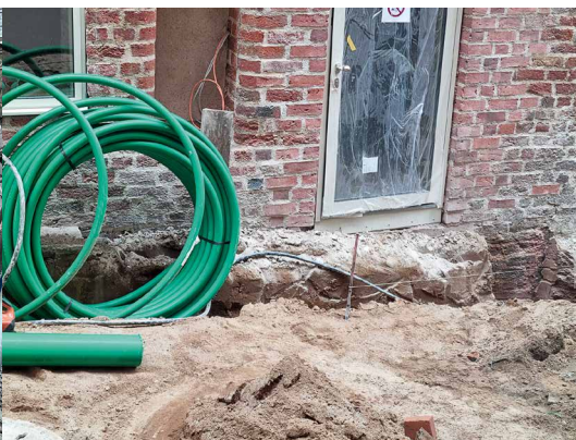
Abb. 14: Für die Abdichtung der Keller- und Sockelwände wurde ein Ton-Lehm-Sand-Gemisch aufgebracht | © Nina Greve]
