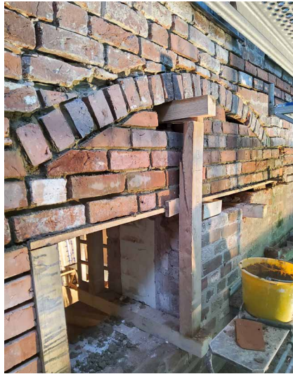
Abb. 22: Die Fensteröffnung erhielt einen waagerechten Sturz. Der historische Bogen darüber wurde saniert. [© Nüthen]
