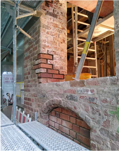
Abb. 19: Links neben dem neuen Spitzbogenportal wurde auch die für Lübecker Dielenhäuser typische große Fensteröffnung geschaffen [© Nüthen]
