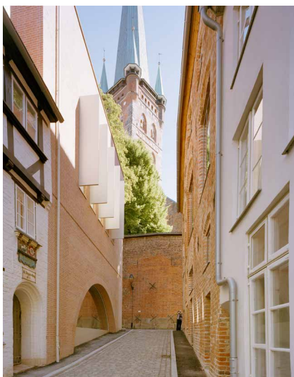
Abb. 4: An der Ecke Kolk und Kleine Petersgrube entstand der Neubau für das Figurentheater ... [© Konermann Siegmund Architekten BDA Stadtplaner/Alexander de Cuveland]
