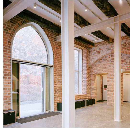
Abb. 23: Foyer mit Eingangsportal und großem Fenster; die historischen Deckenbalken wurden mit einer Stahlkonstruktion ertüchtigt [© Konermann Sigmund Architekten BDA Stadtplaner / Alexander de Cuveland]
