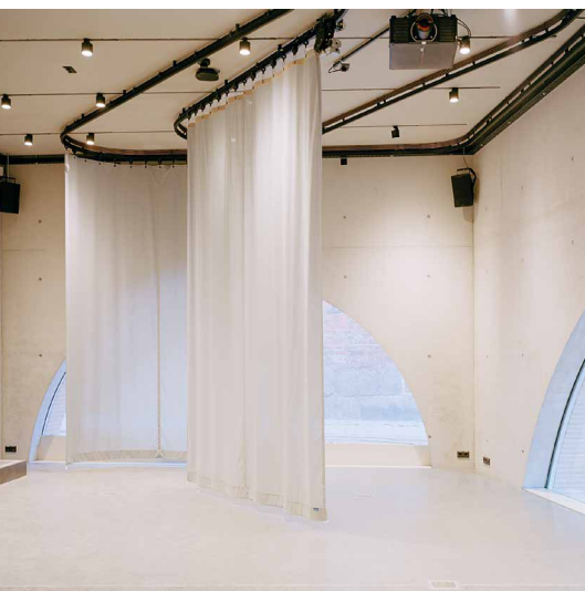
Abb. 24: Im Forum des Neubaus war der Planungsaufwand für die Sichtbetonschalung besonders hoch [© Konermann Siegmund Architekten BDA Stadtplaner / Alexander de Cuveland]
