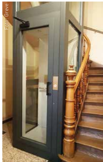
Ein Lift im Treppenauge des historischen Stiegenhauses kann sehr klein ausfallen.
